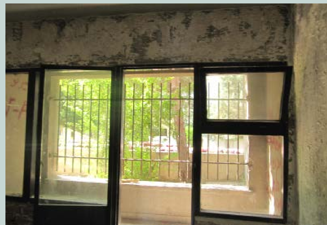
خوابگاه ۱۶ قبل از بازسازی
